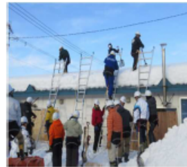
雪下ろし実技講習
